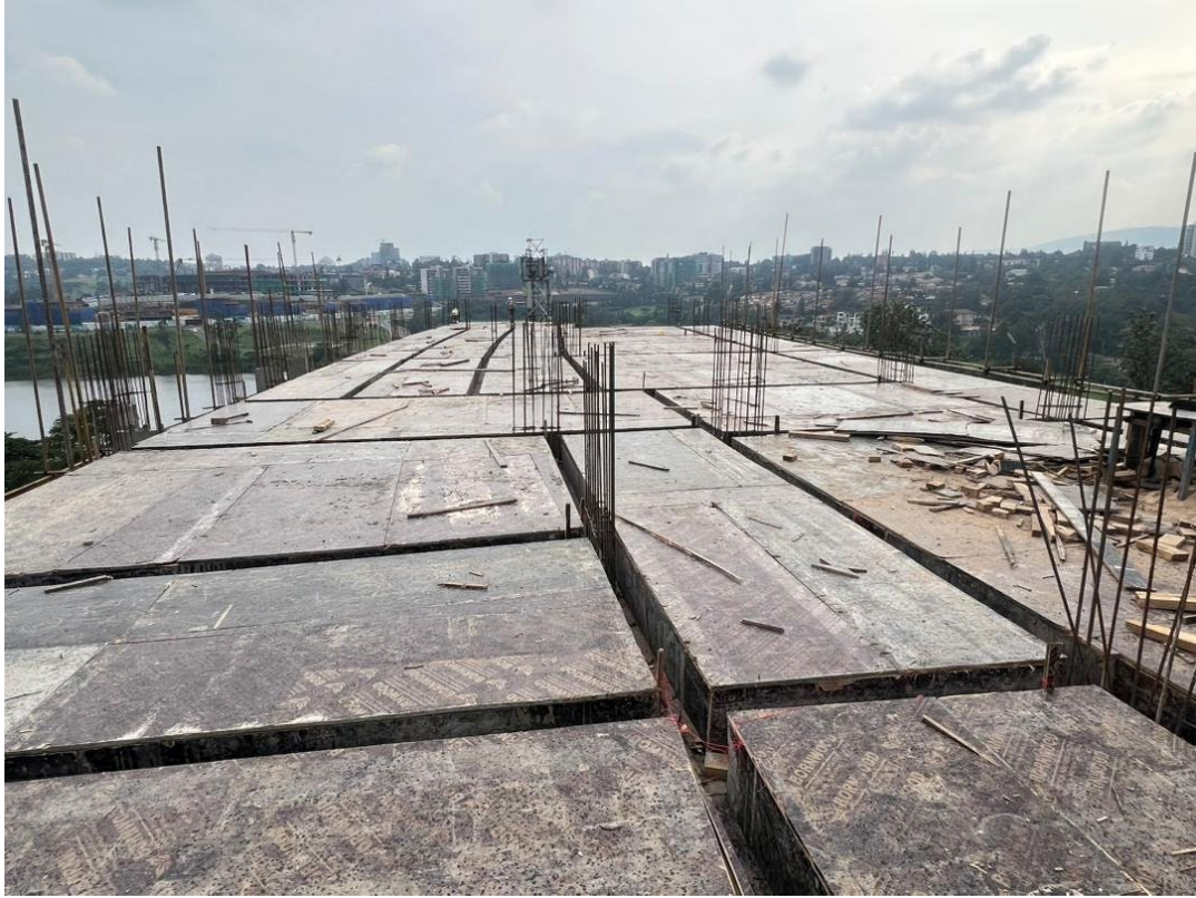
Phase 3&4: slab progress
