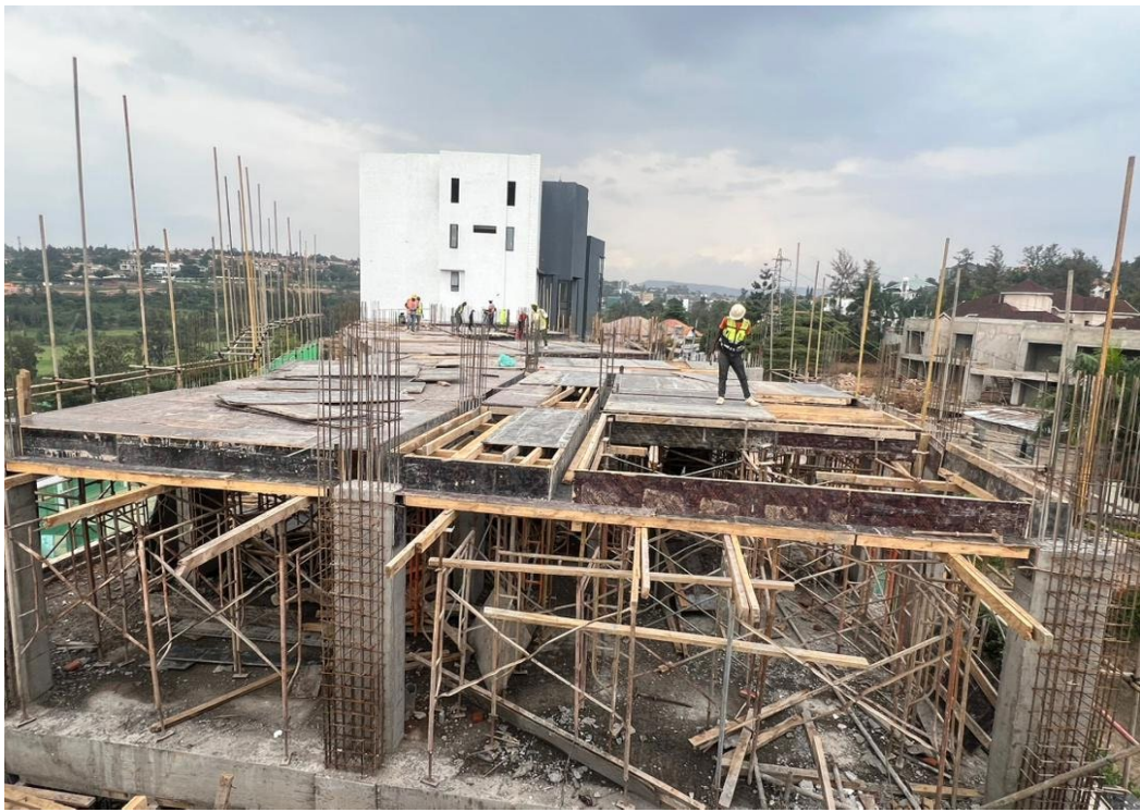
Phase 3&4: slab progress
